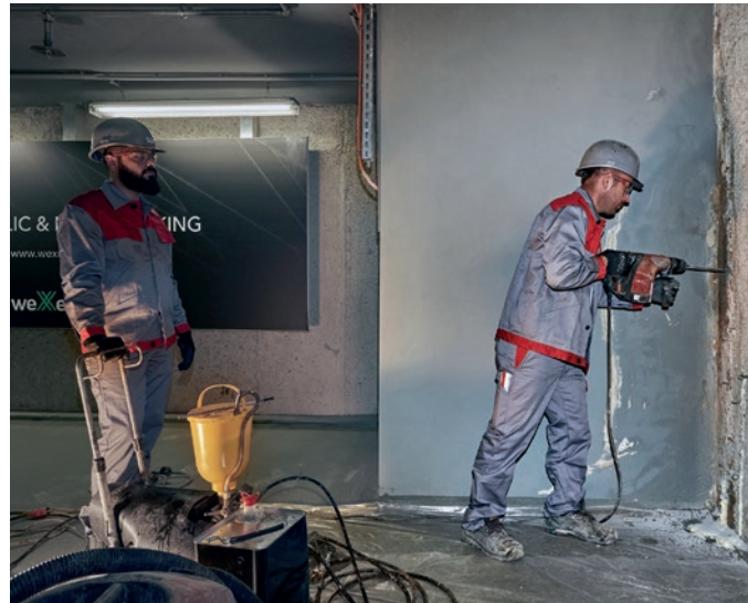
■ Verpressen von Schlitzwandfugen
